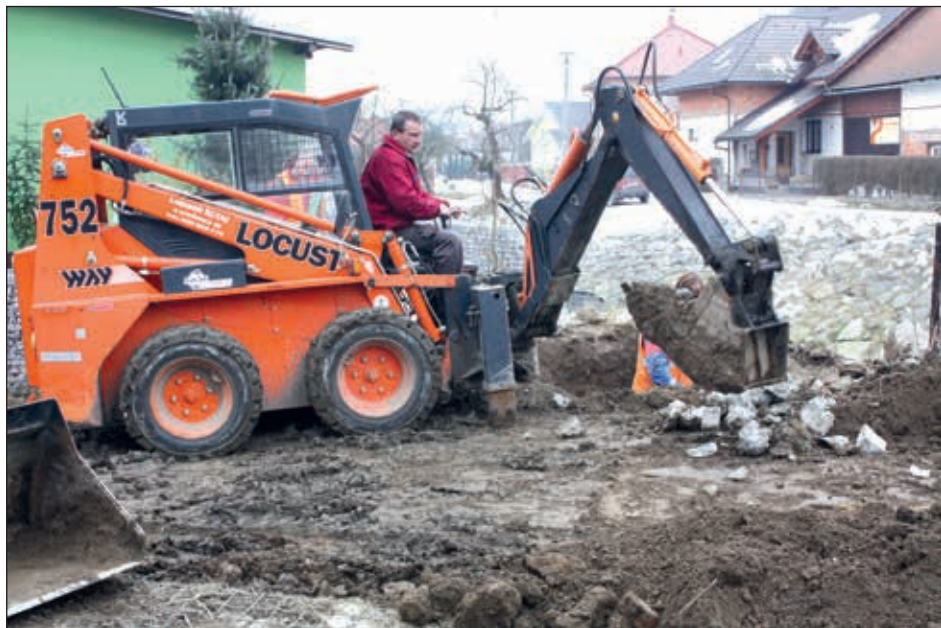
Stavba lávky u Stabravů
